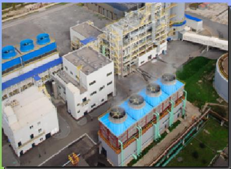
**Новый агрегат гранулированного карбамида мощностью 500 тыс. т/год**
